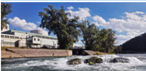
Kühlwasser-Austrittskanal Wassertemperatur 32°
